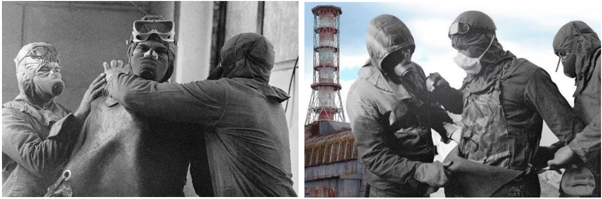
Рисунок 27 — Применение защитных слоев из свинца для защиты от \gamma -излучения давало в основном психологический эффект
