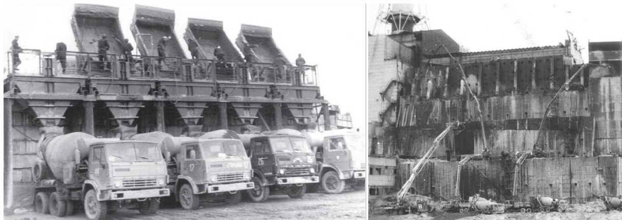
Рисунок 32 — Пример предотвращения разноса радиоактивного загрязнения: перегрузка бетона на маршруте от бетонного завода до бетонных насосов
