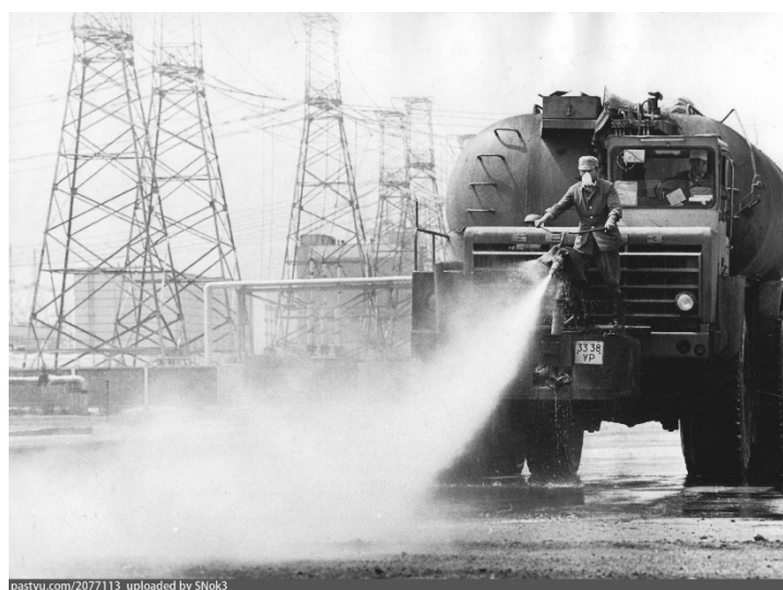
Рисунок 31 — Вот так наносили пылеподавляющий состав
