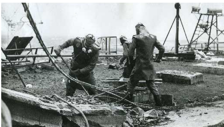
Рисунок 5 — Сбор радиоактивных отходов на кровле
