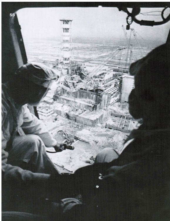
Рисунок 6 — Старший научный сотрудник Института биофизики А.В. Симаков проводит измерения мощности дозы \gamma -излучения над аварийным реактором
