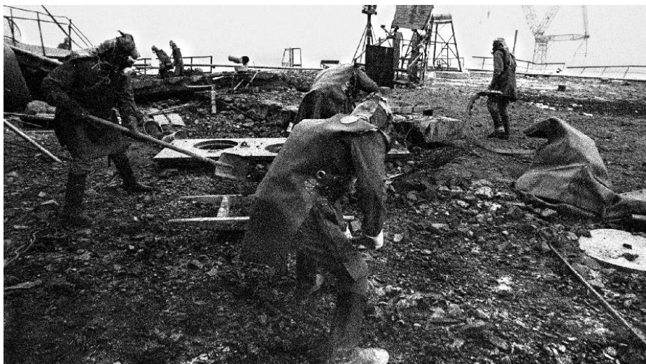
Рисунок 4 — Сбор радиоактивных отходов на кровле
