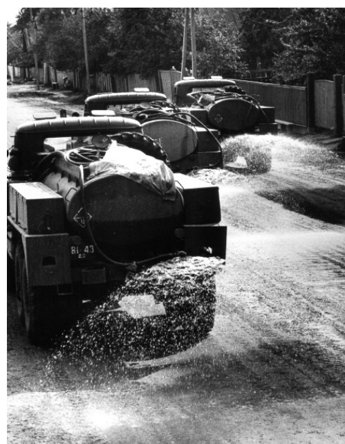
Рисунок 31 — Вот так наносили пылеподавляющий состав
