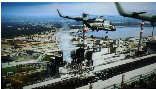
Рисунок 8 — Сброс в реактор различных материалов
